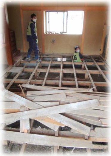
床板をはがして、床下のへドロを取りだす作業
