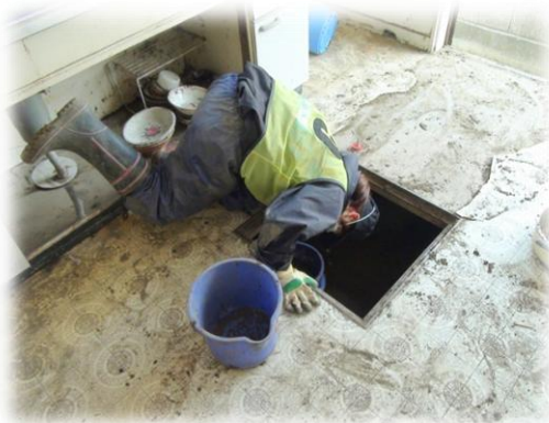
台所から床下に潜り込んで、 床下のヘドロを取りだす
