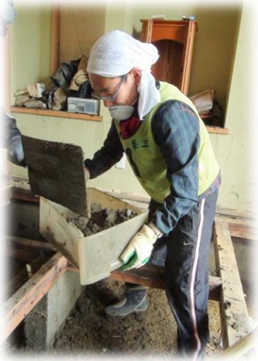
床板をはがして、床下のへドロを取りだす作業
