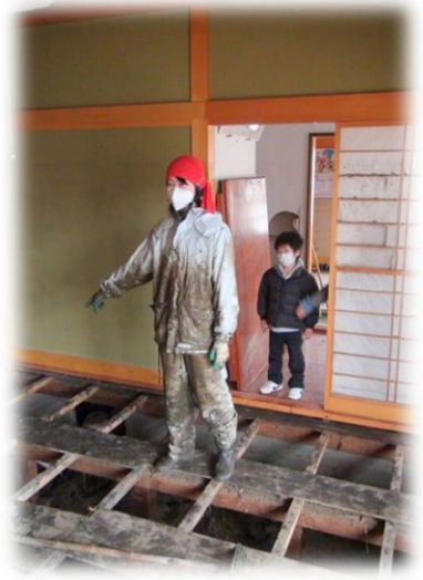
床板をはがして、床下のへドロを取りだす作業
