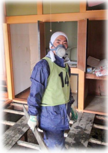
床板をはがして、床下のへドロを取りだす作業
