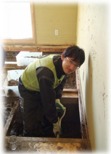
床板をはがして、床下のへドロを取りだす作業
